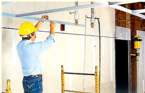
Mit Deckenstativ oder Säulenklammer ist der selbstnivellierende LaserLevel innerhalb von Sekunden einsatzbereit. Auf ein bestimmtes Höhenmaß wird er durch die Feineinstellung am Stativ oder an der Säulenklammer gebracht. Vor Beginn der Montage kann mit einem Blick festgestellt werden, ob z. B. die Fensterfront in Waage ist oder zu tief hängende Be- oder Entlüftungsröhre stören. Sein Einsatz steigert die Arbeitsproduktivität zwischen 30 und mehr als 50 % bei erhöhter Genauigkeit.
