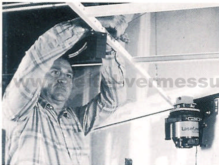
LaserLevel Modell 1142 im horizontalen Einsatz beim Abhängen von Zwischendecken. Durch den Wandhalter Modell L1196 ist der LaserLevel direkt an der Decken- unterkonstruktion befe- stigt.
