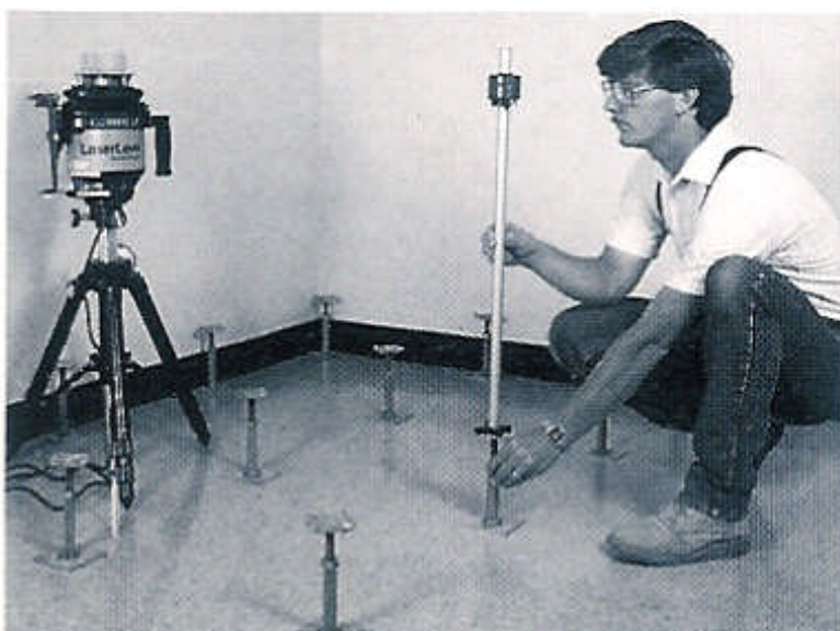
Wie beim Einbau von Decken wird auch hier durch den LaserLevel der Arbeitsablauf erheblich verbessert und die Ge- nauigkeit gesteigert.
